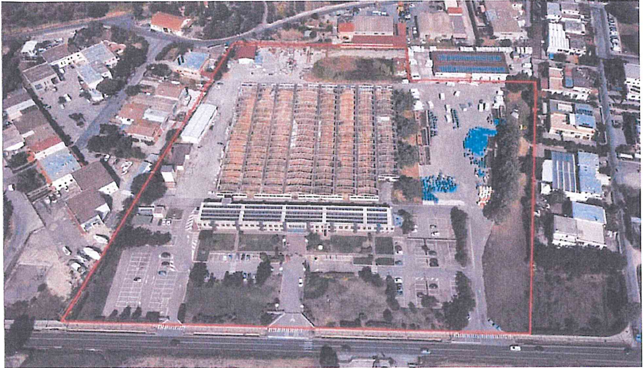
Conad a Castiglione, l'area dell'intervento complessivo, il supermercato verrà nella zona a destra
