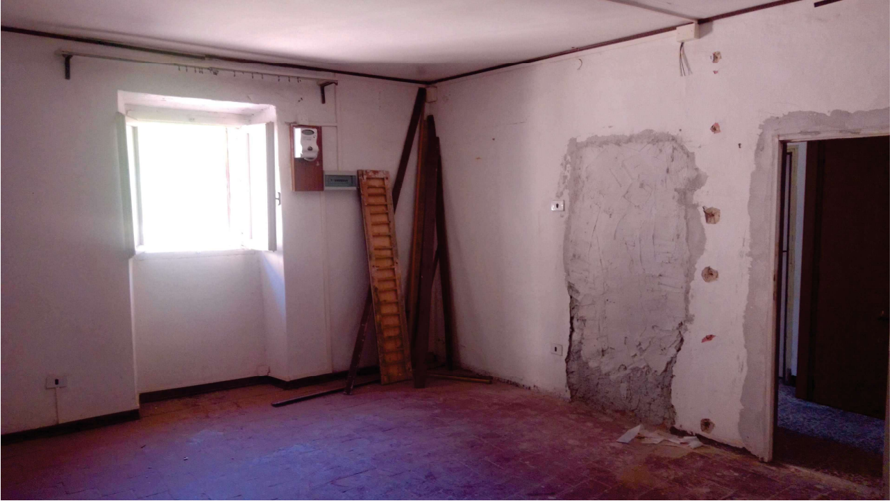
LOCALE LATO OVEST
