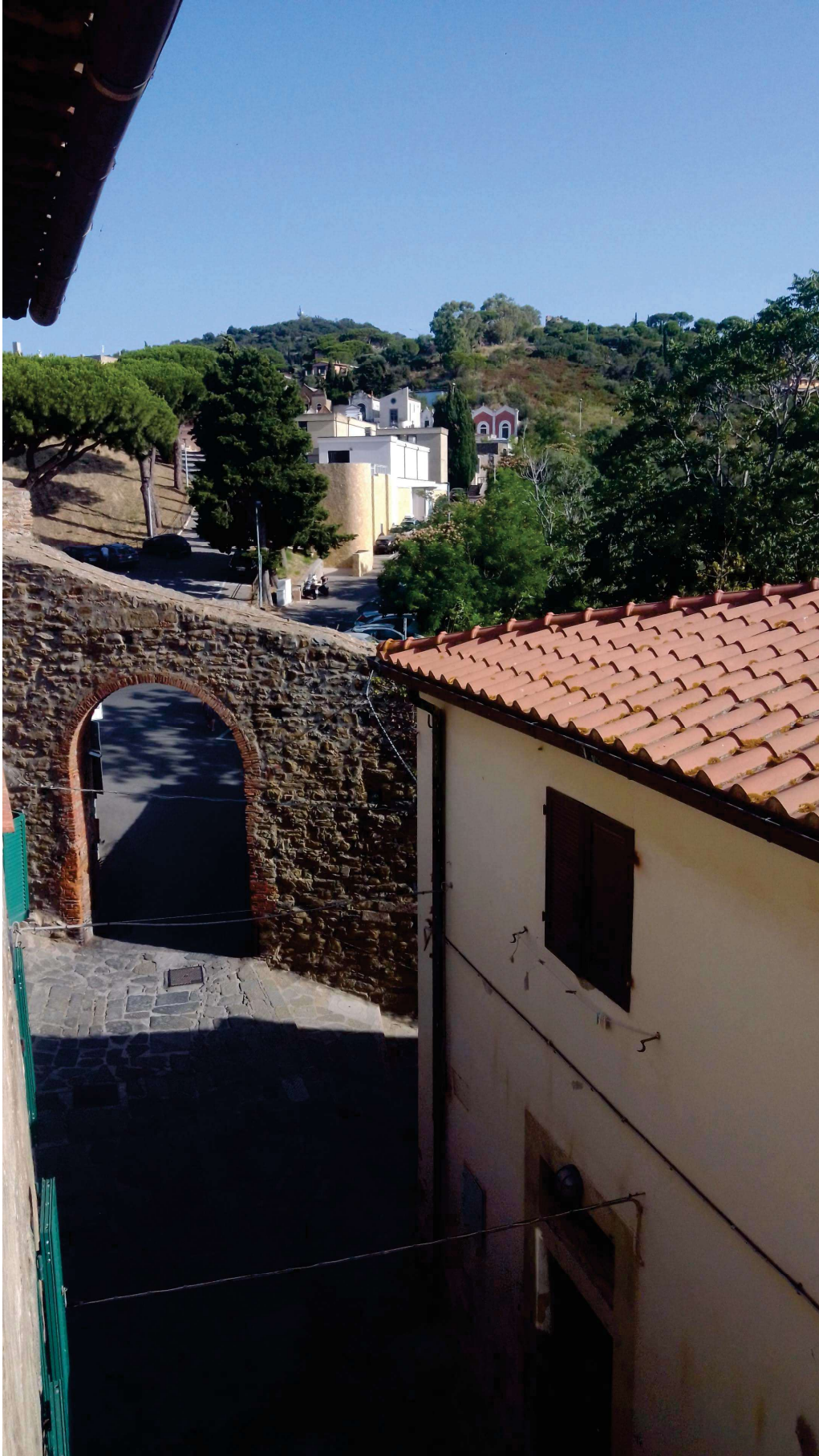
VISTA PANORAMICA MURA MEDIEVALI
