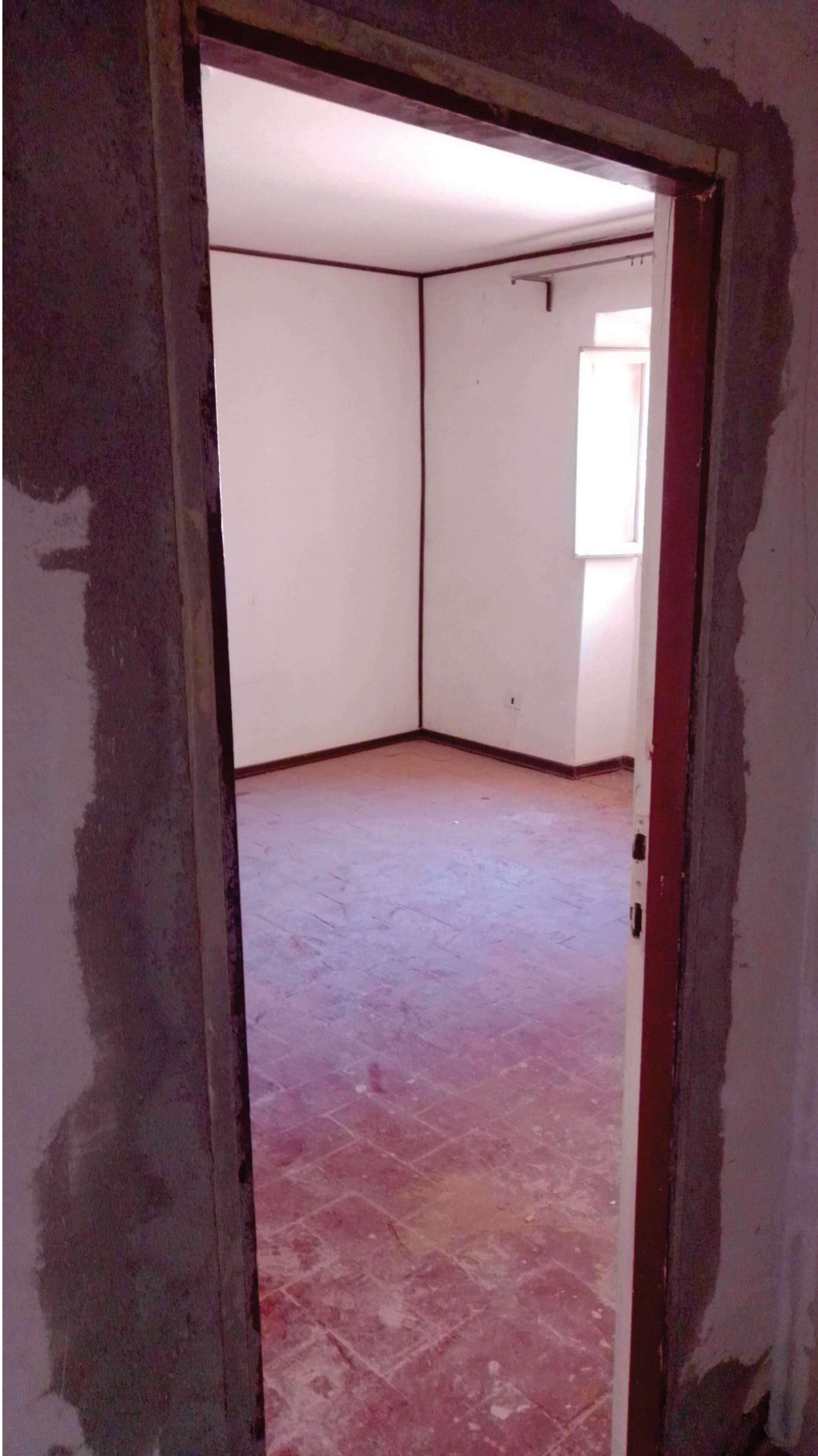
INGRESSO DA DISIMPEGNO SU LOCALE LATO OVEST
