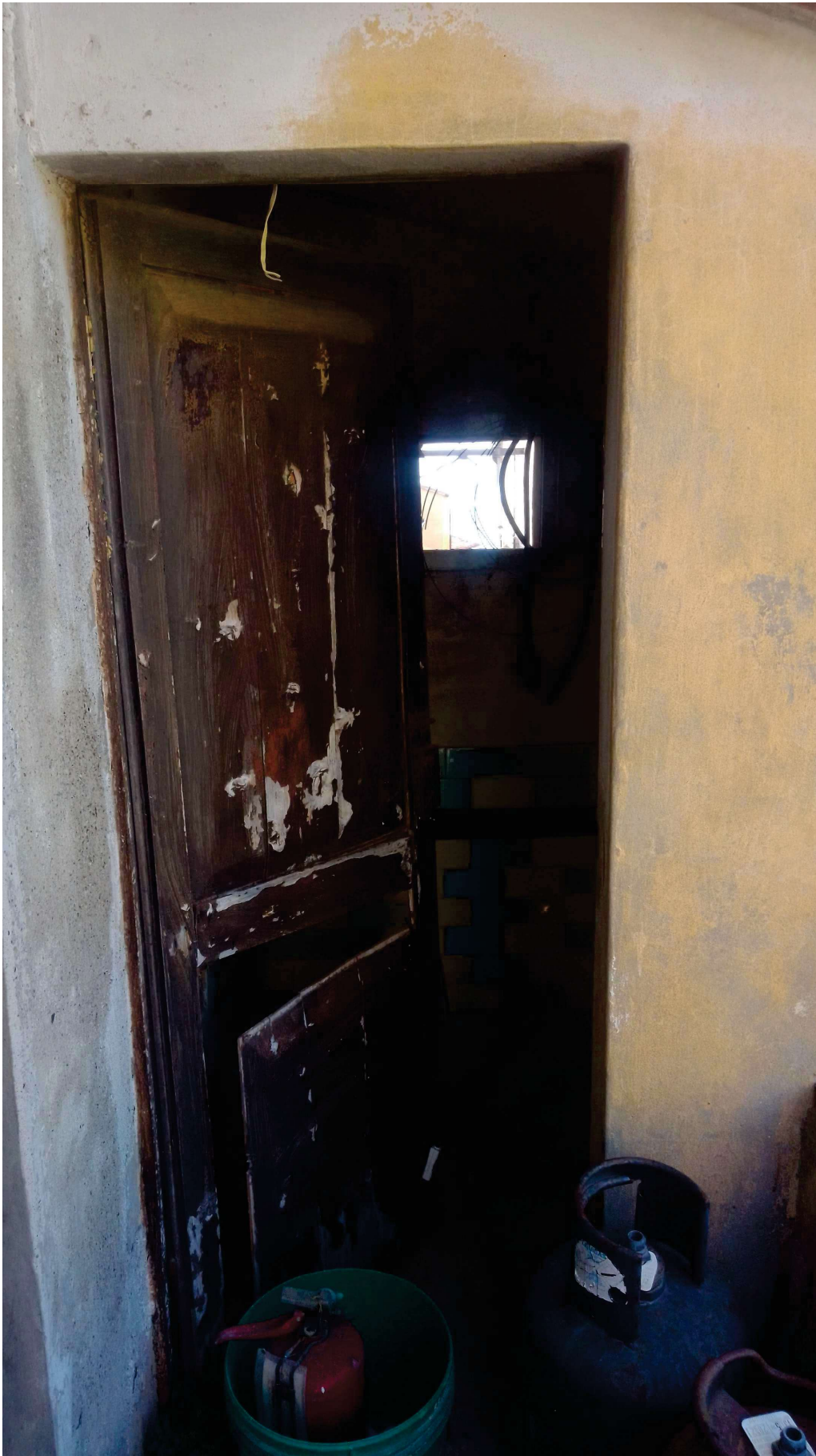
INGRESSO RIPOSTIGLIO DA SCALA ESTRENA COMUNE
